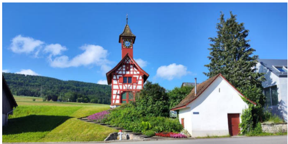
Abbildung 64 Aufnahme Zythüsli mit Kleinbaute im Vordergrund (Foto: Büro für Baugeschichte)
