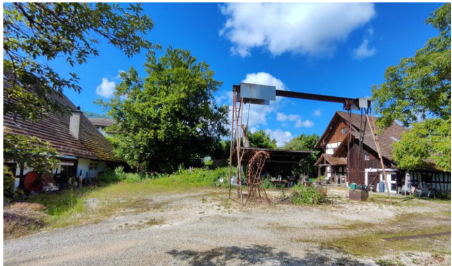
Abbildung 65 Aufnahme Zythüsilstrasse 3, (Foto: Büro für Baugeschichte)
