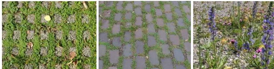
Abbildung 55 Beispiele von sickerfähiger Materialisierung des Bodens
