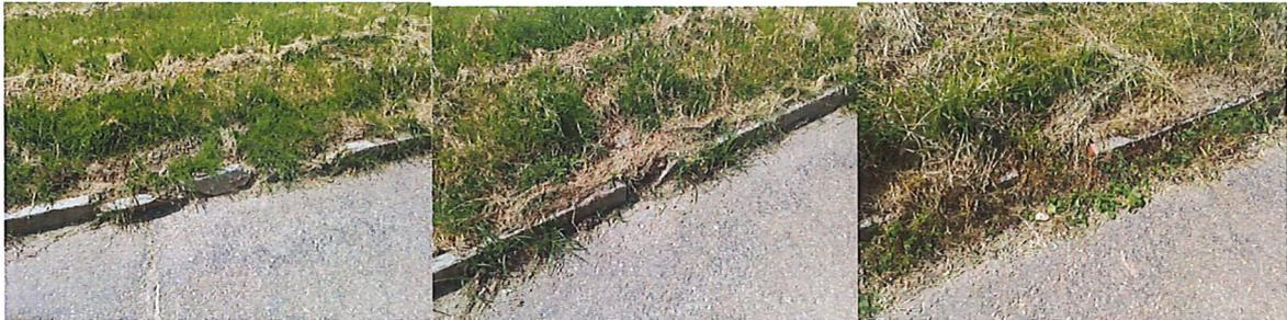
**Abbildung 7 Schäden an Randabschlüssen südseitig**
