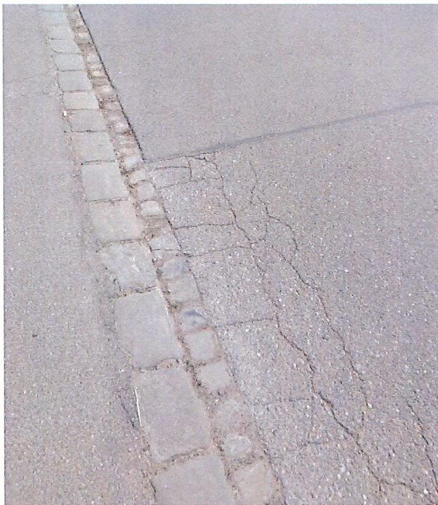
Abbildung 8 Beispielfoto Randabschluss Fahrbahn/Gehweg
