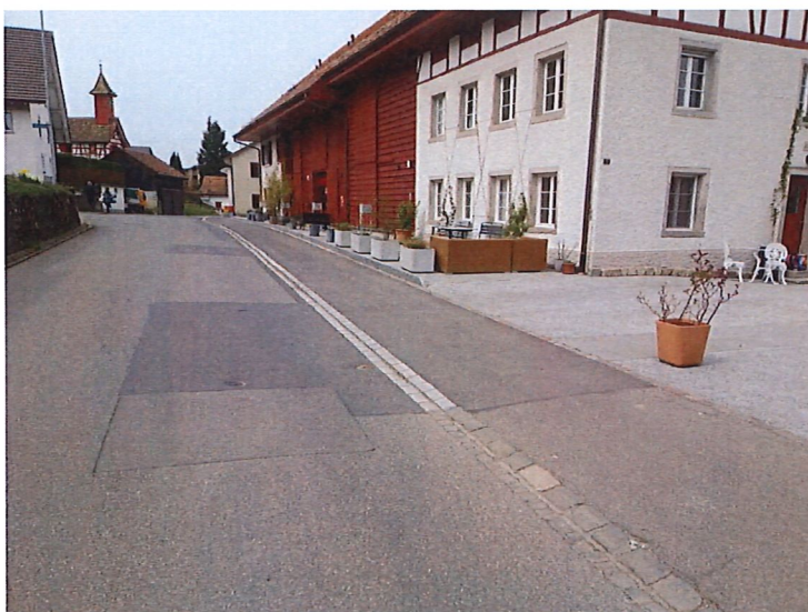
Abbildung 7 Neuer Belag bei Liegenschaft Haus 8 bis 10b
