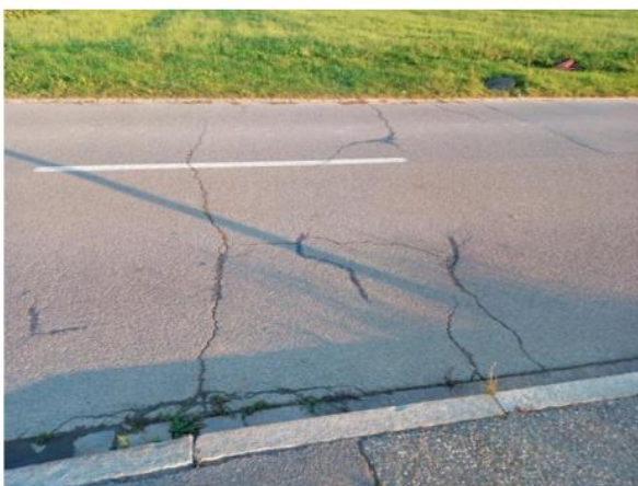
Typische Schadensbilder bei Belag und Randabschlüssen.
