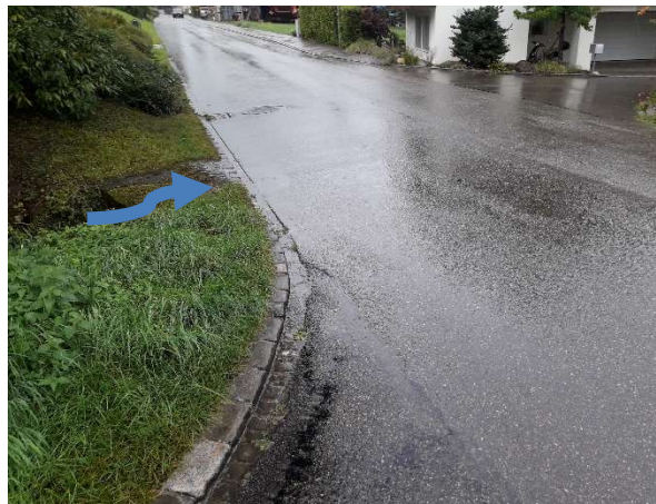
Querungsbereich des Leibachs unter der Dorfstrasse und dem Leibachweg.
