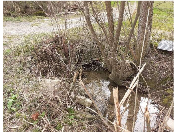
Zufahrt bei Durchlass e6.
