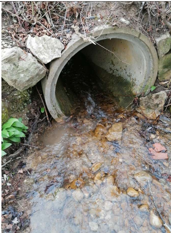
Sh3.3 DN800 Sohle Einlauf: 465.854 Sohle Auslauf: 465.661
