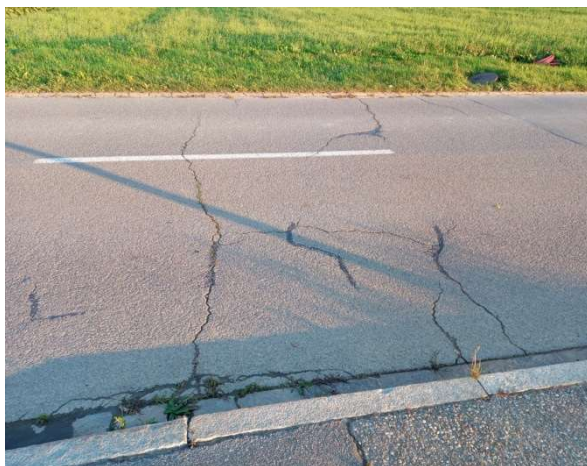
Typische Schadensbilder bei Belag und Randabschlüssen.
