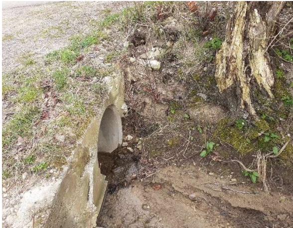
Einlauf Durchlass e6.
