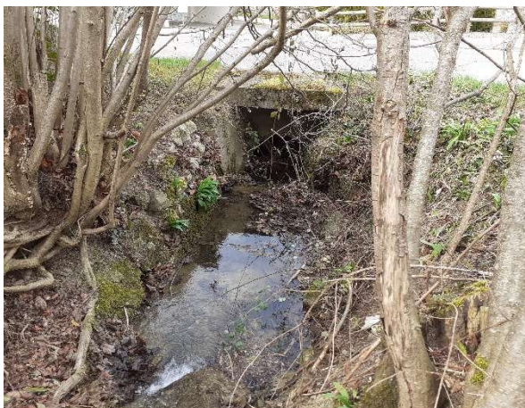
Einlauf Durchlass e5 unter der Dorfstrasse.
