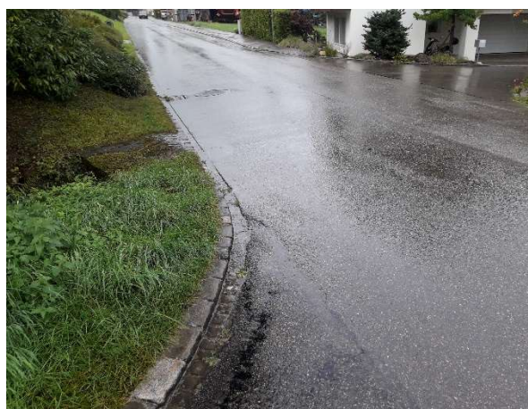
Dorfstrasse ab Querstrasse Leibachstrasse in Richtung Dorfzentrum Schleinikon.
