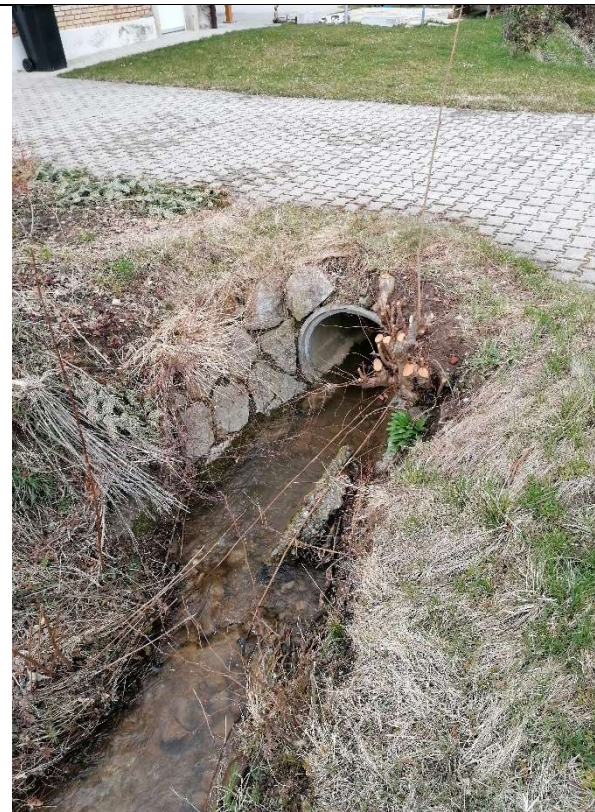
Sh4: DN700 Sohle Einlauf: 463.829 Sohle Auslauf: 463.685
